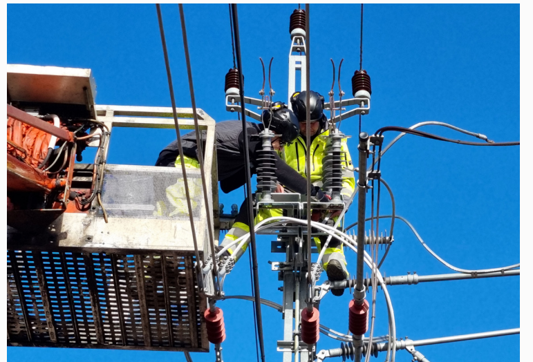
Installation des Freiluftschaltgerätes von Hughes.
