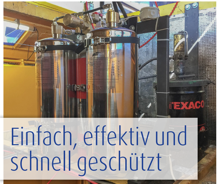
Feuerlöschanlage FALCON® für den Motorschutz installiert.
