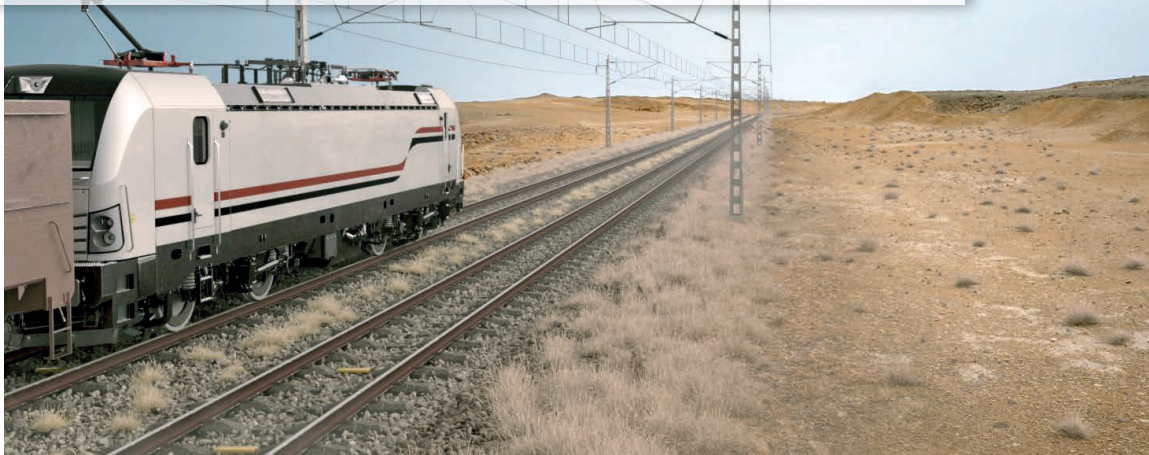
Les 660 premiers kilomètres de voies sur un total de 1 800 kilomètres ont été commissionnés.
